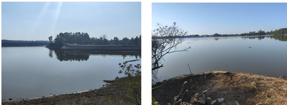
图 2.1-1 岸线现状照片
