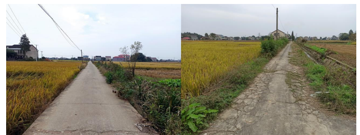
图 2-7 莲花塘村内部道路现状
