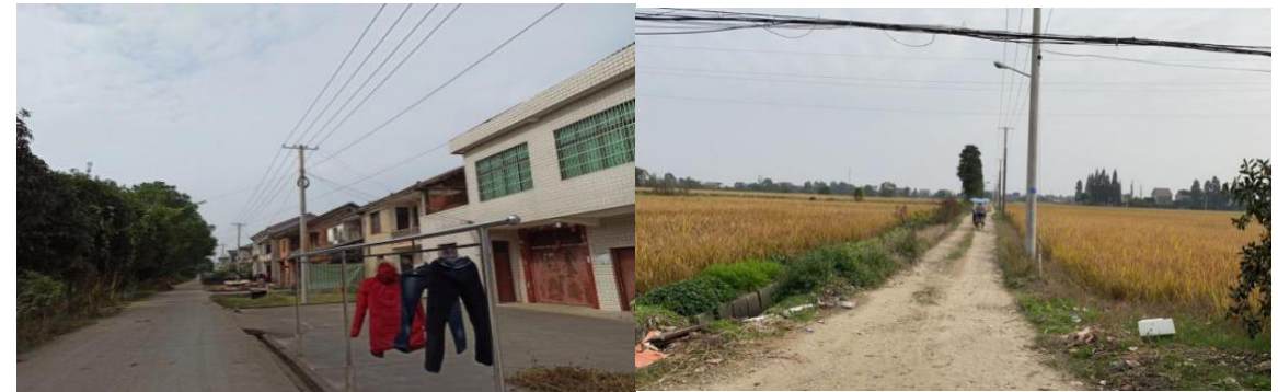
图 2-6 金石村内部道路现状
