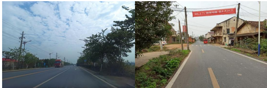
图 2-4 金石村对外道路现状
