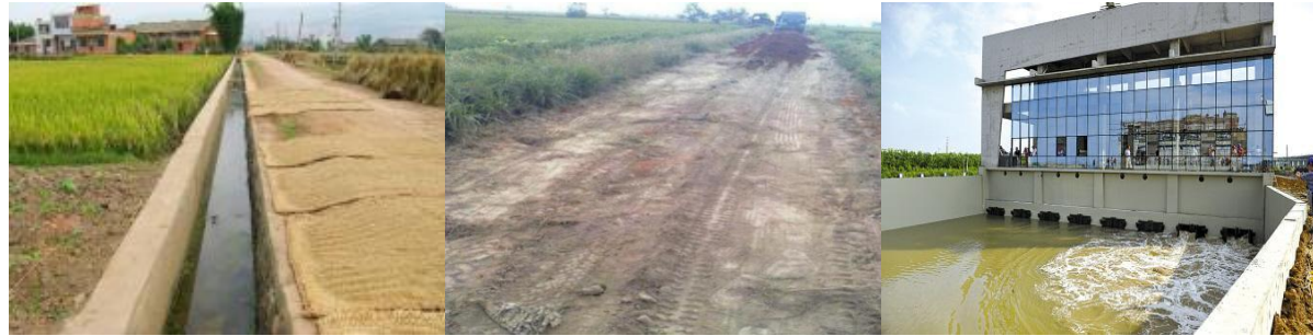
硬化沟渠整修机耕道 新建泵站
