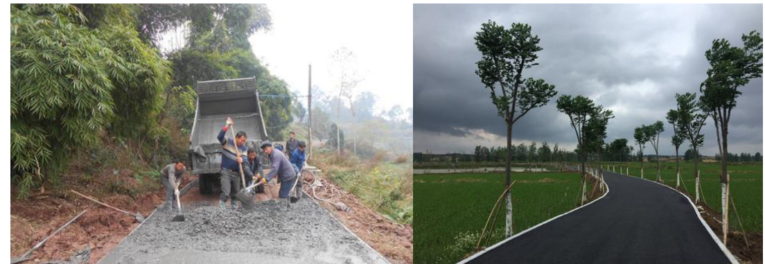
硬化土路 整修道路
